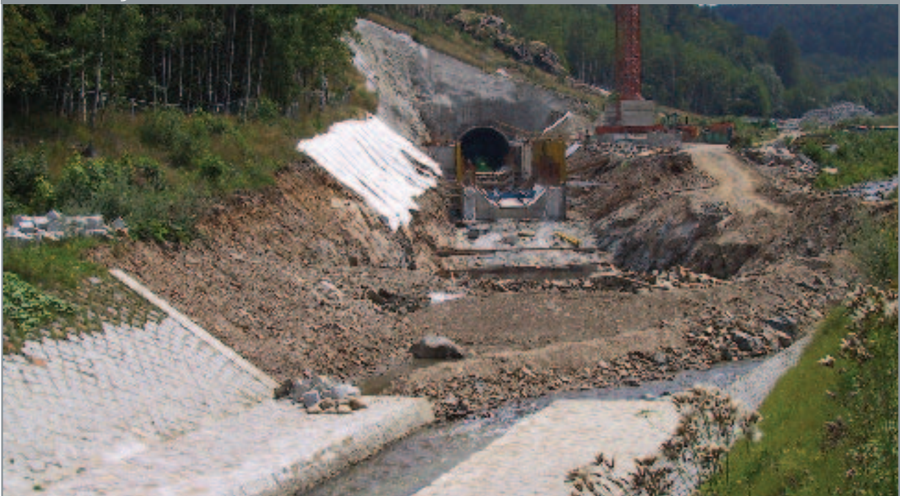
Abb. 13: Baustelle für das Hochwasserrückhaltebecken oberhalb Lauenstein (Foto: S. Schümborg 2003)
