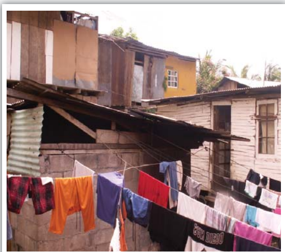
Figura 8. Fotografía: Casas y ranchos ubicados zonas de alto riesgo, aumentando la vulnerabilidad de sus habitantes, precario Copey, Jaco, Puntarenas.
