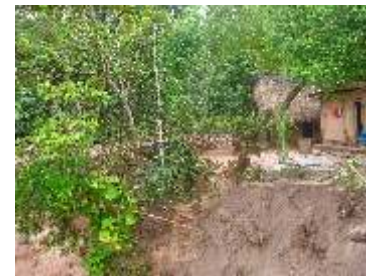
Zona vulnerable a deslizamiento
