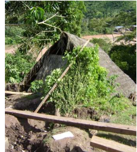
Vivienda afectada por deslizamiento
