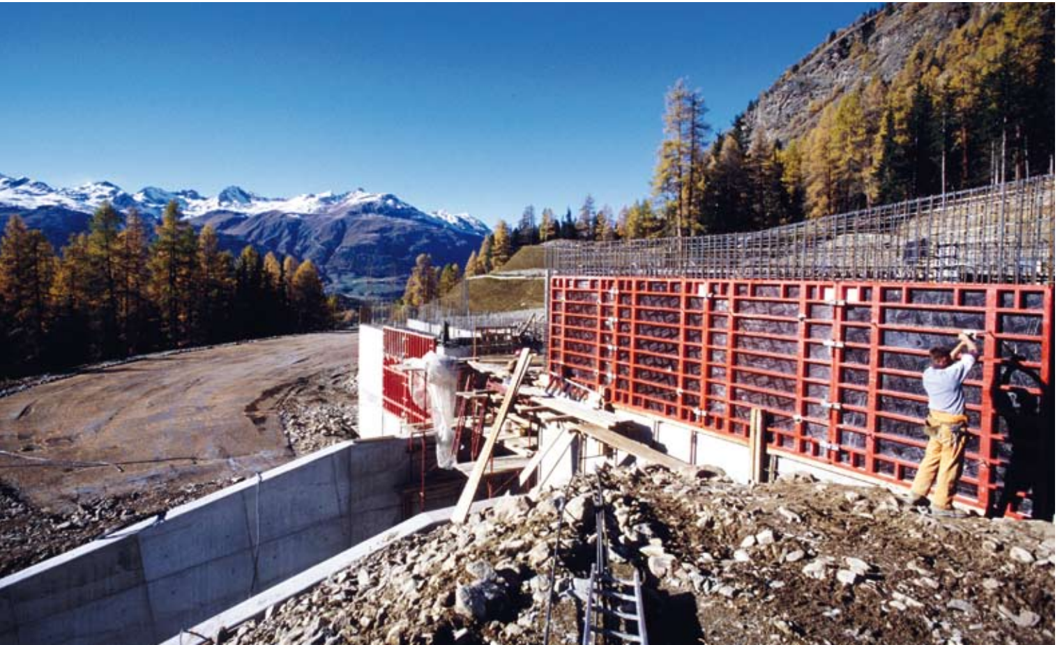
Cette digue située au pied du Schafberg – achevée depuis lors – protège la localité de Pontresina (GR) contre les laves torrentielles, les avalanches et les chutes de pierres.
