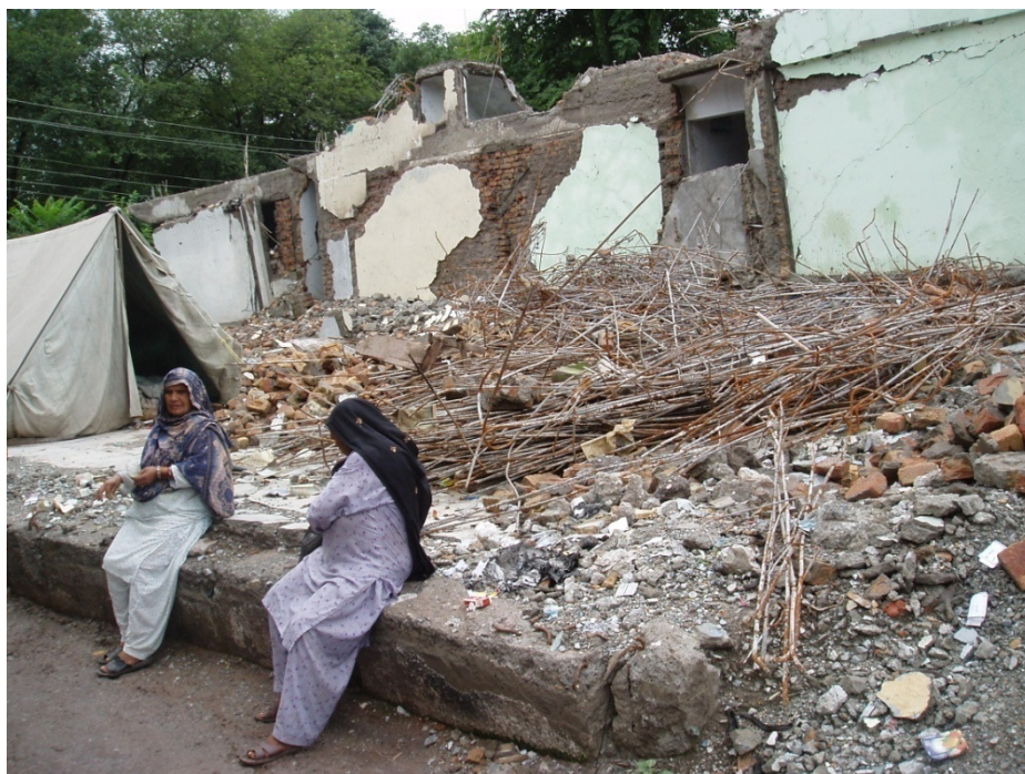
Расми № 2. Қисмати кӯҳани шаҳр дар наздикии вайронаҳои таърихи. Хишти оддӣ. 30-70 сол. Аз ибтидо ин иморати сеошёна буд; танҳо девори қафоӣ иморат боқи мондааст. Арматура ба қисмати вайроншуда вобастагӣ надорад. Замини соф.
