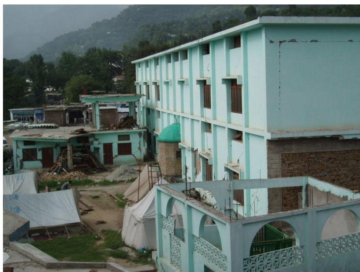
Расми № 6. Қисмати шарқии маҳаллаи истиқоматӣ дар домани кӯҳ. Замини соф. Ҳамаи иморатҳои кабуд аз тарафи як ширкат бо усули монанд сохта шудаанд. Зарари ҳадди аққал – якчанд деворҳои майдаи харобшуда. 10-20 сола.
