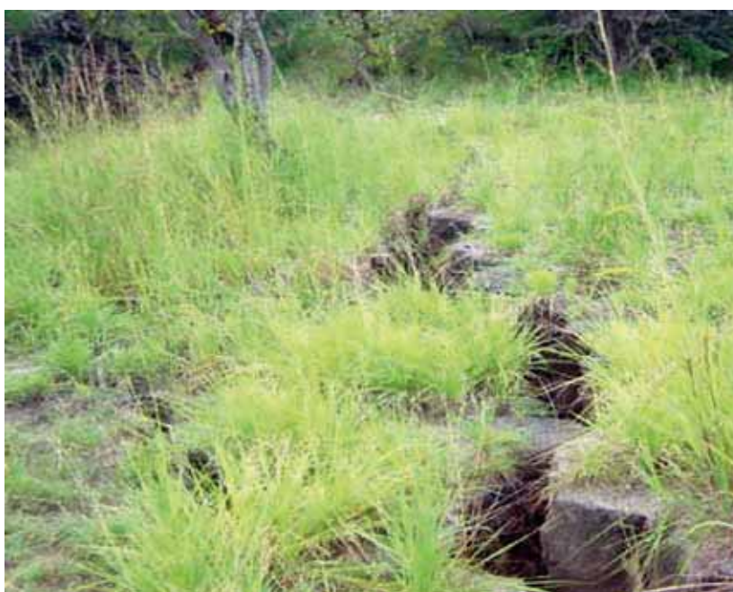
Une faille causée par le séisme de 2006 dans le district de Machaze
