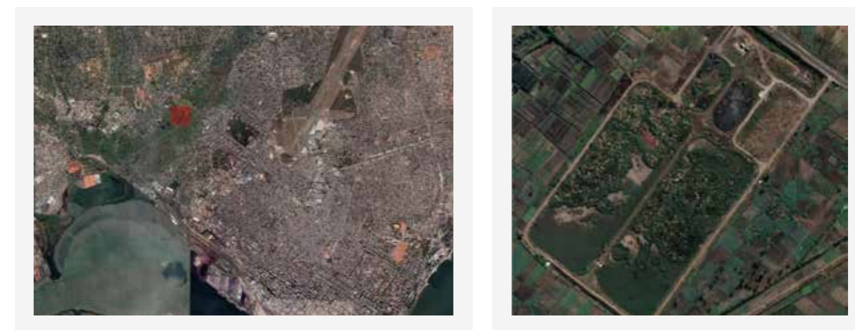
Figura 14: Localização da ETAR na cidade. Em relação ao vale do Rio Infulene (zona de hortas) Pormenor da infraestrutura. Fonte: CRPP com base nas informações fornecidas por google maps (2019).
