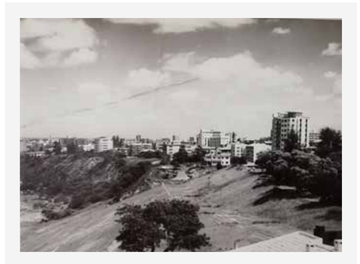
Imagem 14: Terraplanagem e movimentos de terra para a construção da via de descida para a Baix. Fonte: Arquivo fotográfico do Conselho Municipal de Maputo.
