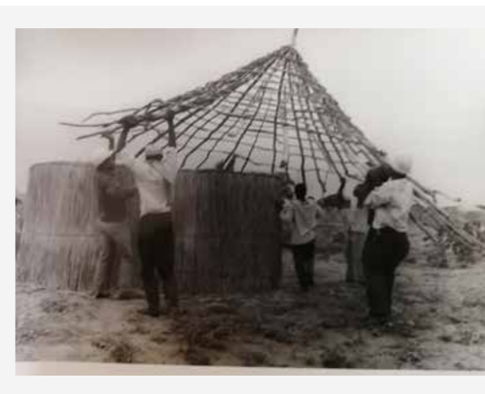
Imagem 4: Momentos de construção comunitária das aldeias comunais (fim anos 70-80). Fonte: Arquivo fotográfico do Conselho Municipal de Maputo.
