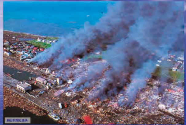
津波来襲後の火災(青苗地区)
