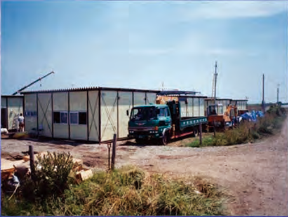
応急仮設住宅
