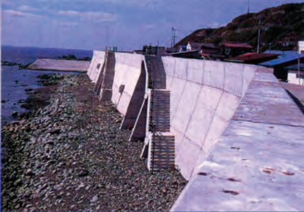
整備された防潮堤
